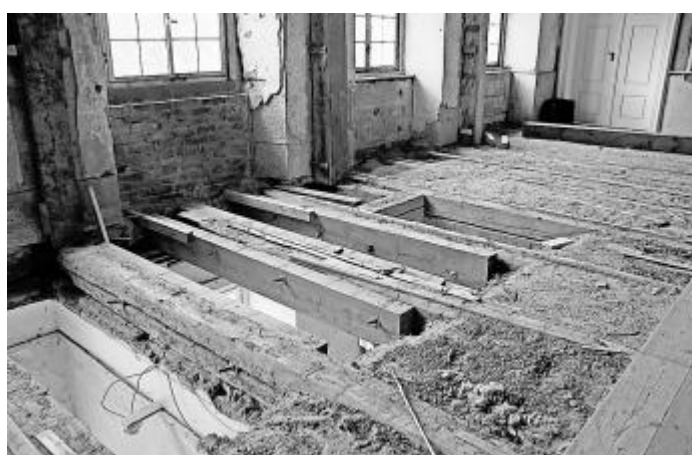
Im Saal des Grafenhauses wird das Gebälk erneuert.
