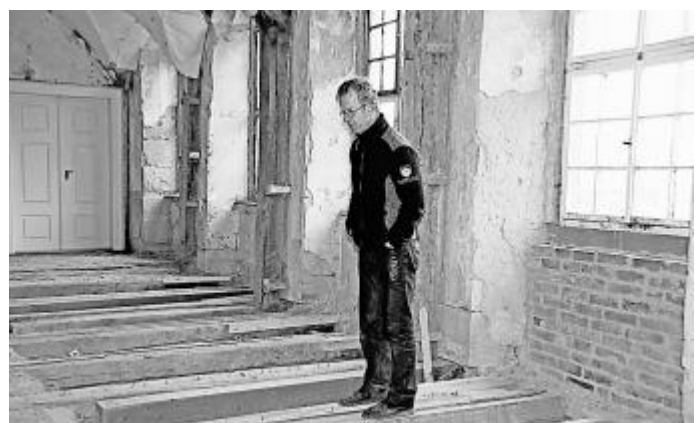
Jugendwerkstattleiter Alexander Mebs erklärt die Arbeiten am Gebälk des Grafenhauses. (Fotos: Kirschner)
